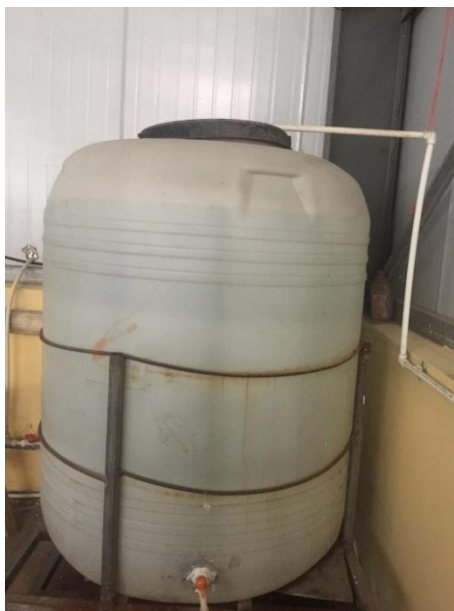
图 3-1 清洗水暂存桶照片
