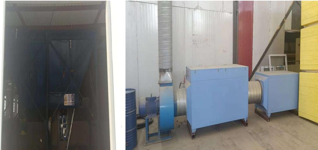
图 4.2-3 本工程废气治理设施（除尘器、除尘器、除尘器、UV 光氧+活性炭）
