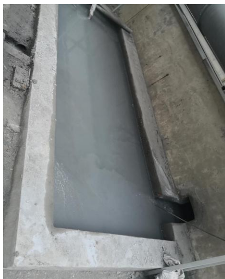
图 4-2 循环沉淀池照片
