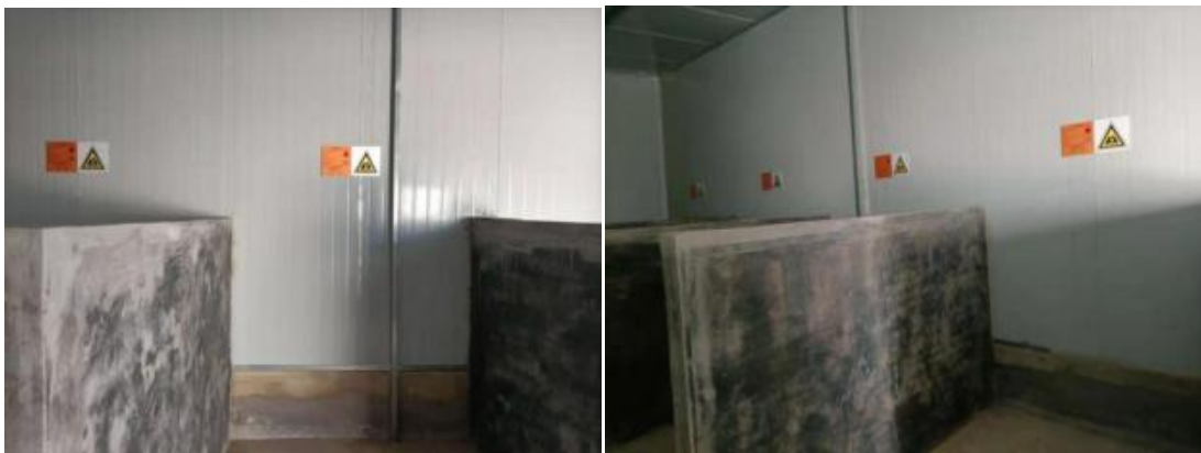
危废间内部建设情况
