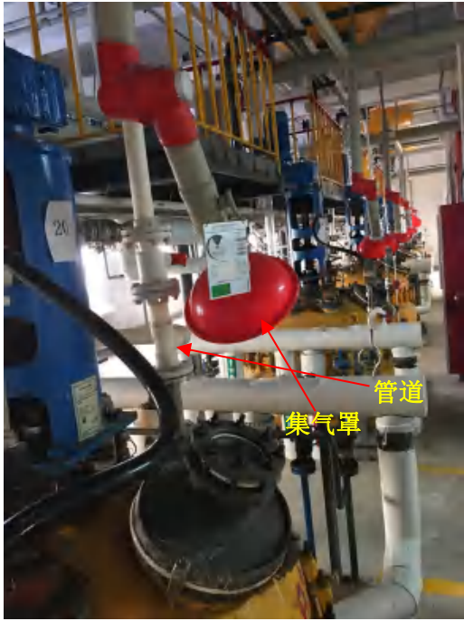
生产设备废气收集
