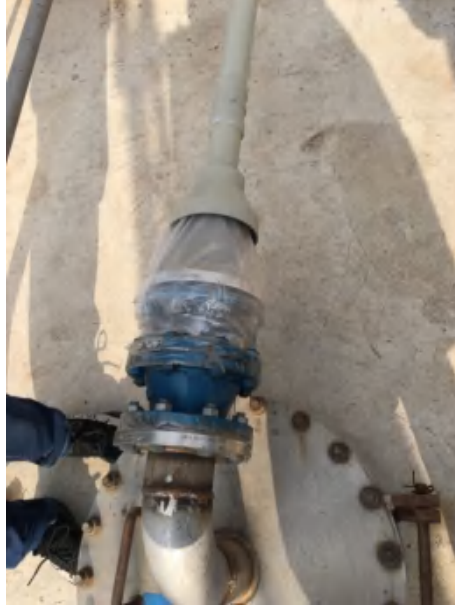
地下储罐废气收集措施
