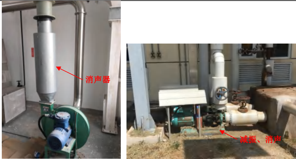
图 4.2-5 降噪措施实际建设情况
