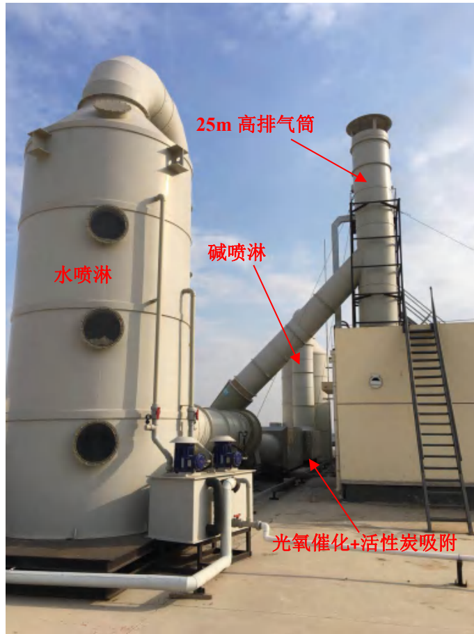
地下储罐废气收集措施
