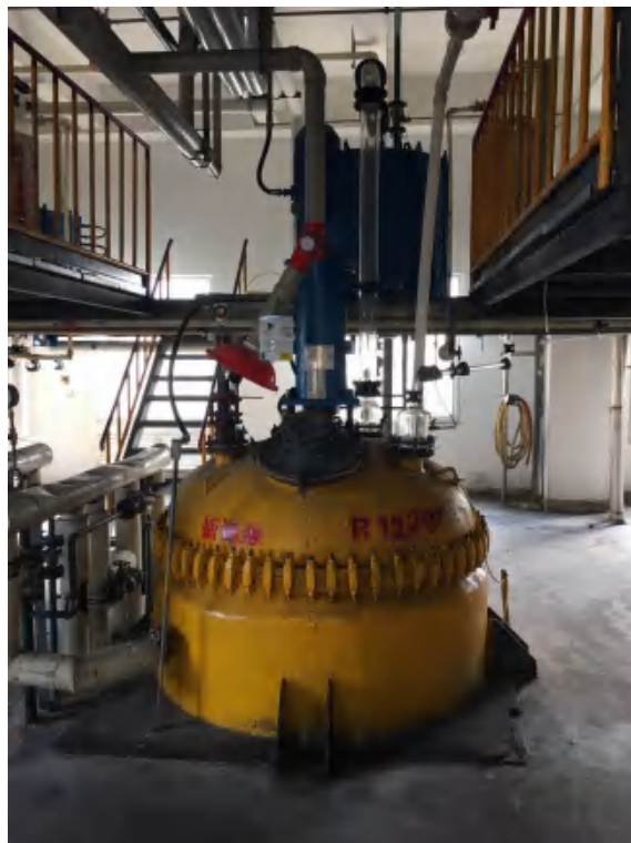
高盐废水蒸发罐
