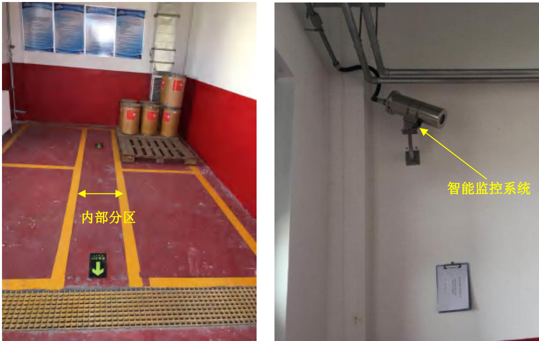
危废间内部建设情况
