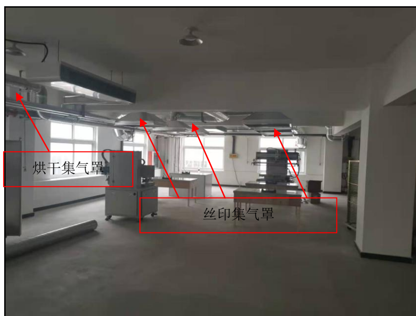
图4.1-1 丝印、烘干工序集气罩实际建设情况
