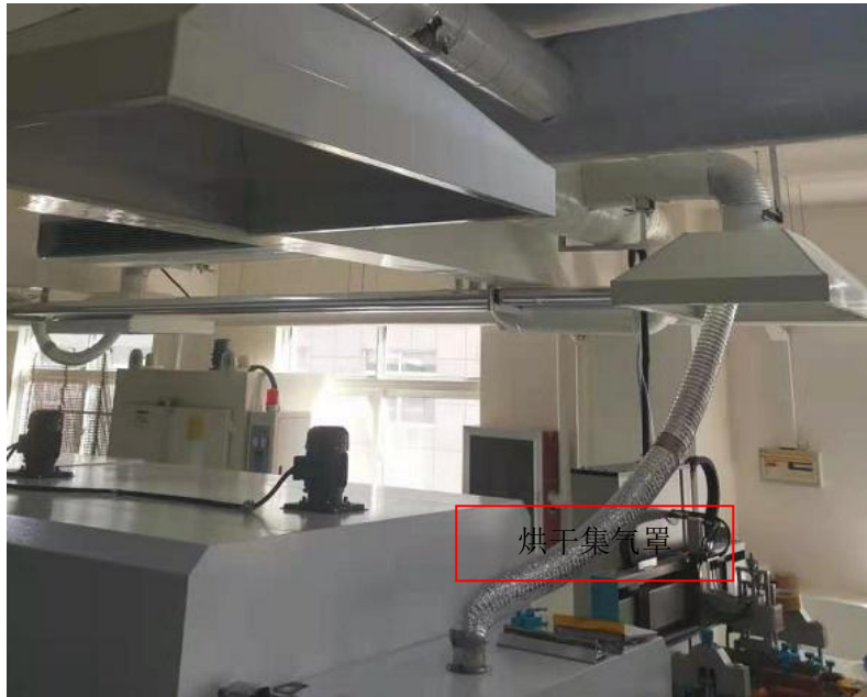
图4.1-3烘干工序集气罩实际建设情况
