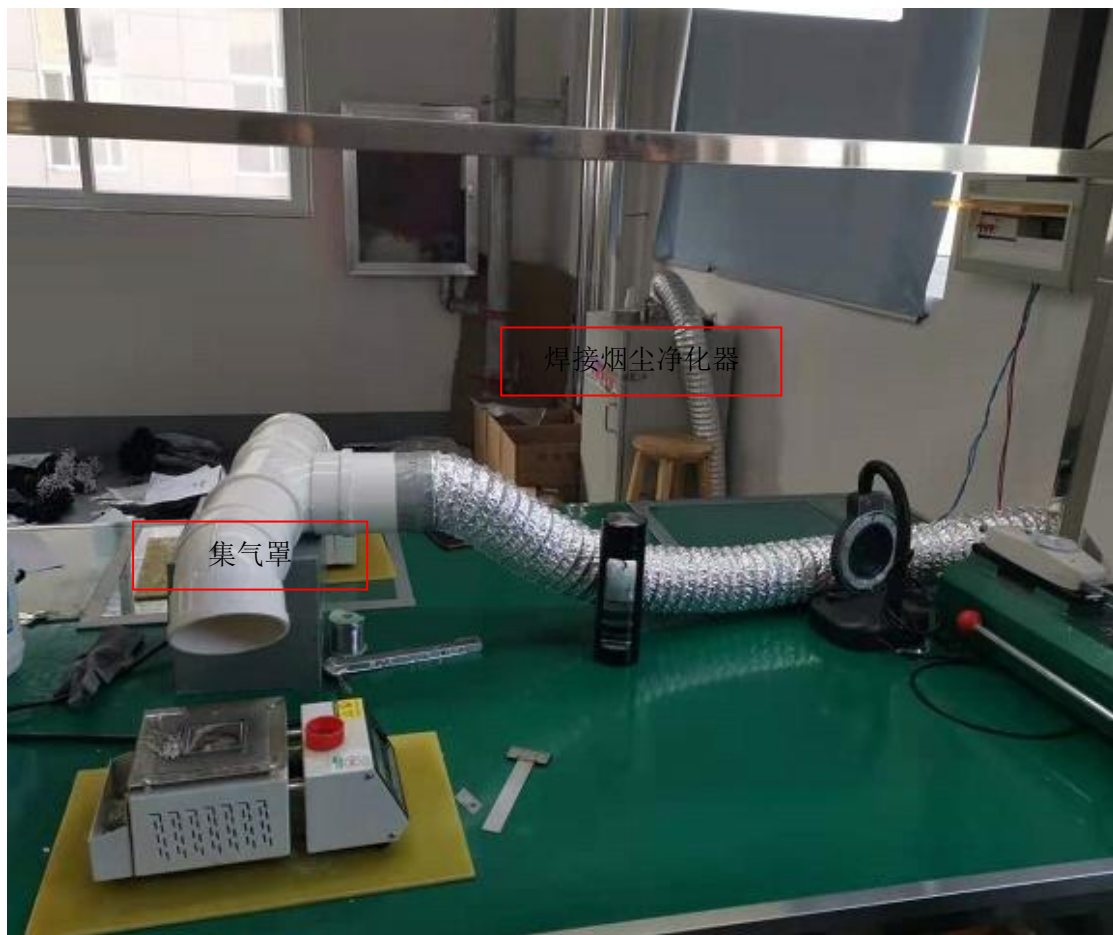
图4.1-6 锡及其化合物废气处理设施实际建设情况
