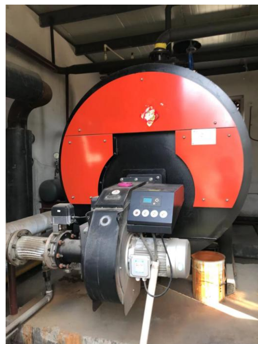
天然气锅炉排气筒、低氮燃烧器
