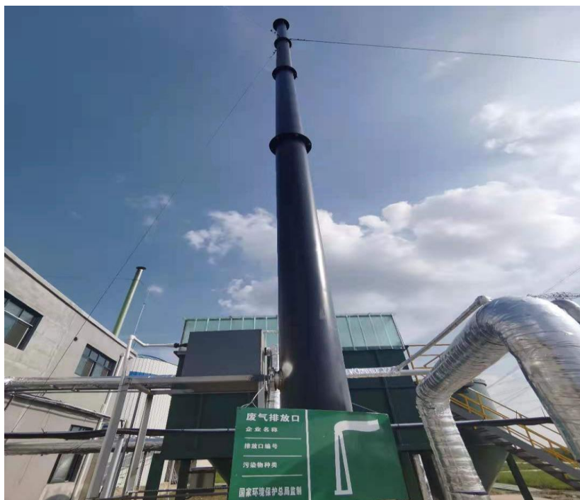
污水区锅炉房排气筒
