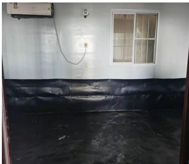
图5.2-4 本项目病死猪暂存间
