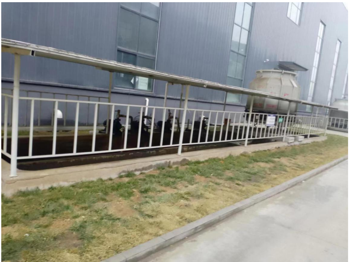
图 4.2-7 地下皂化液池
