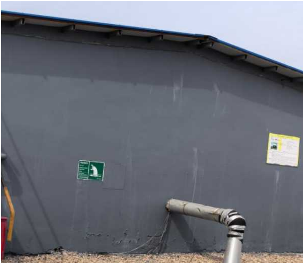
图 4.2.5-5 废水排放口标识牌
