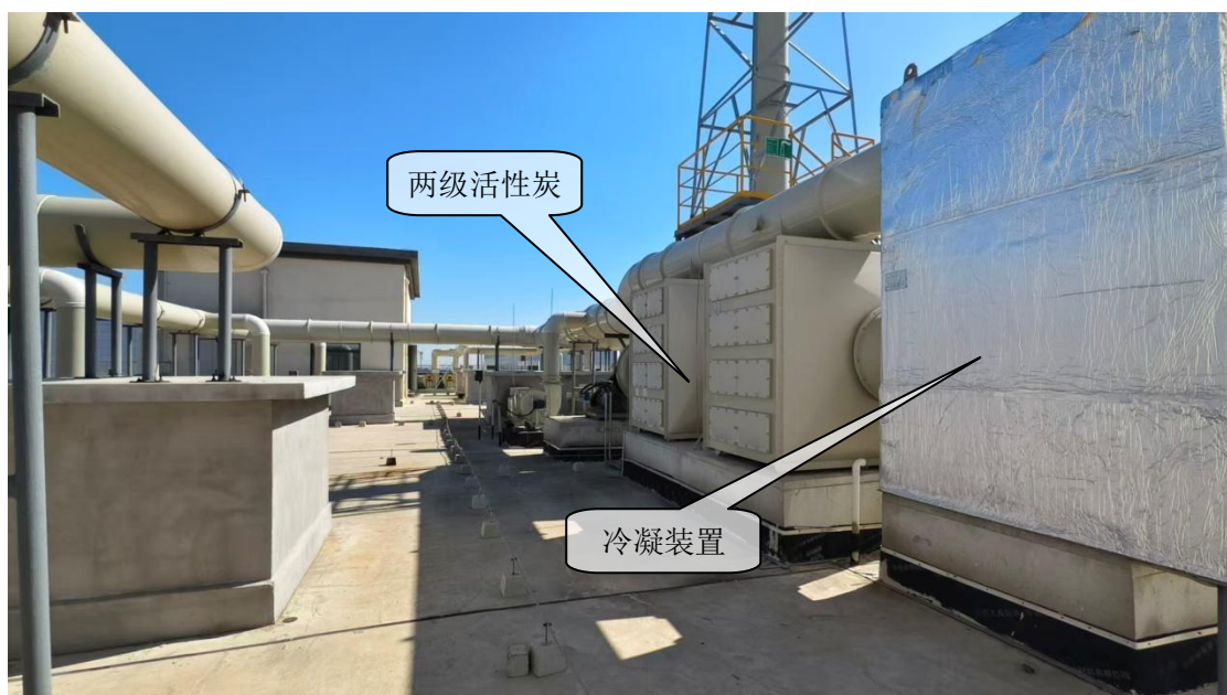
检测中心废气处理-冷凝+两级活性炭
