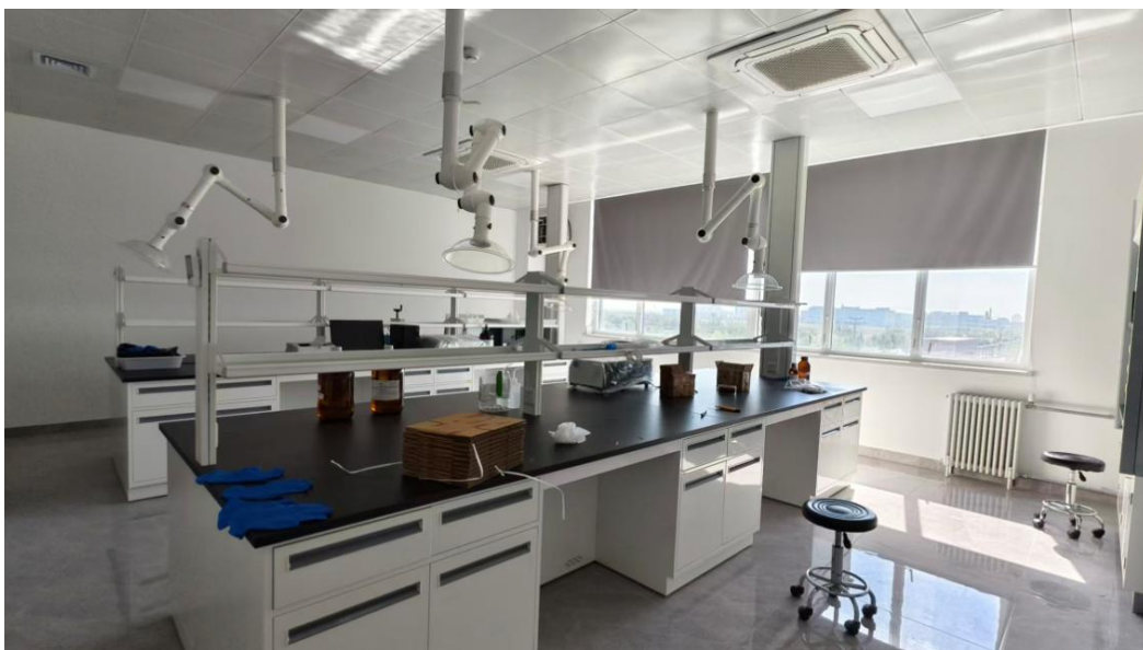
检测中心废气集气罩
