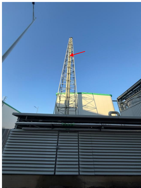
车间及污水处理废气排气筒
