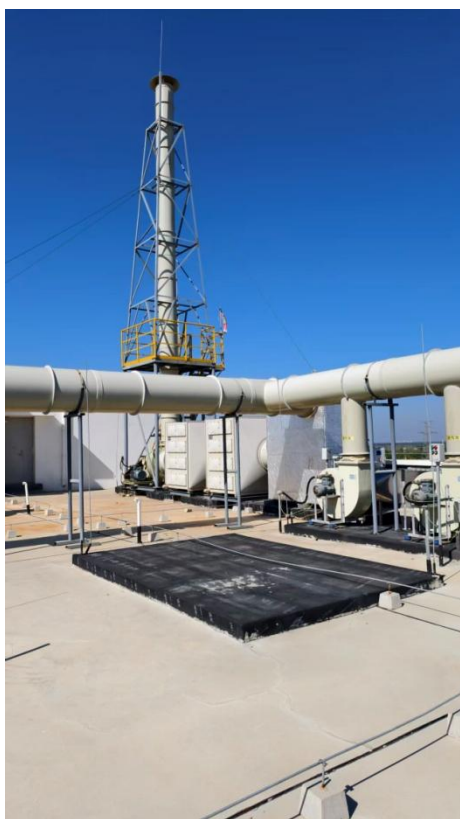
分装废气处理设施-冷凝+两级活性炭、排气筒及采样平台
