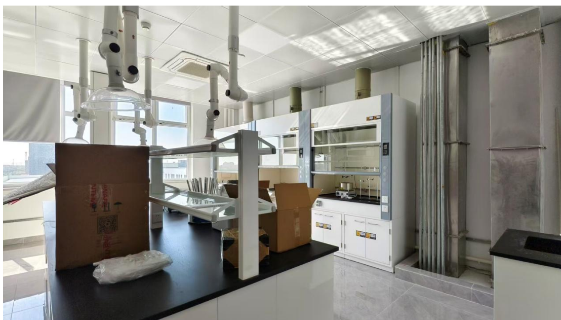
检测中心废气集气罩及通风橱集气管道
